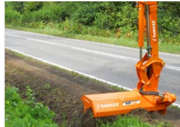
NIVELADORA DE BORDE DE CARRETERA - RP 110
